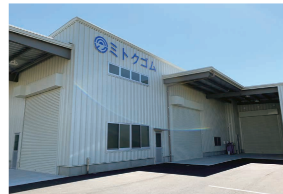
《新設した上浜工場》
